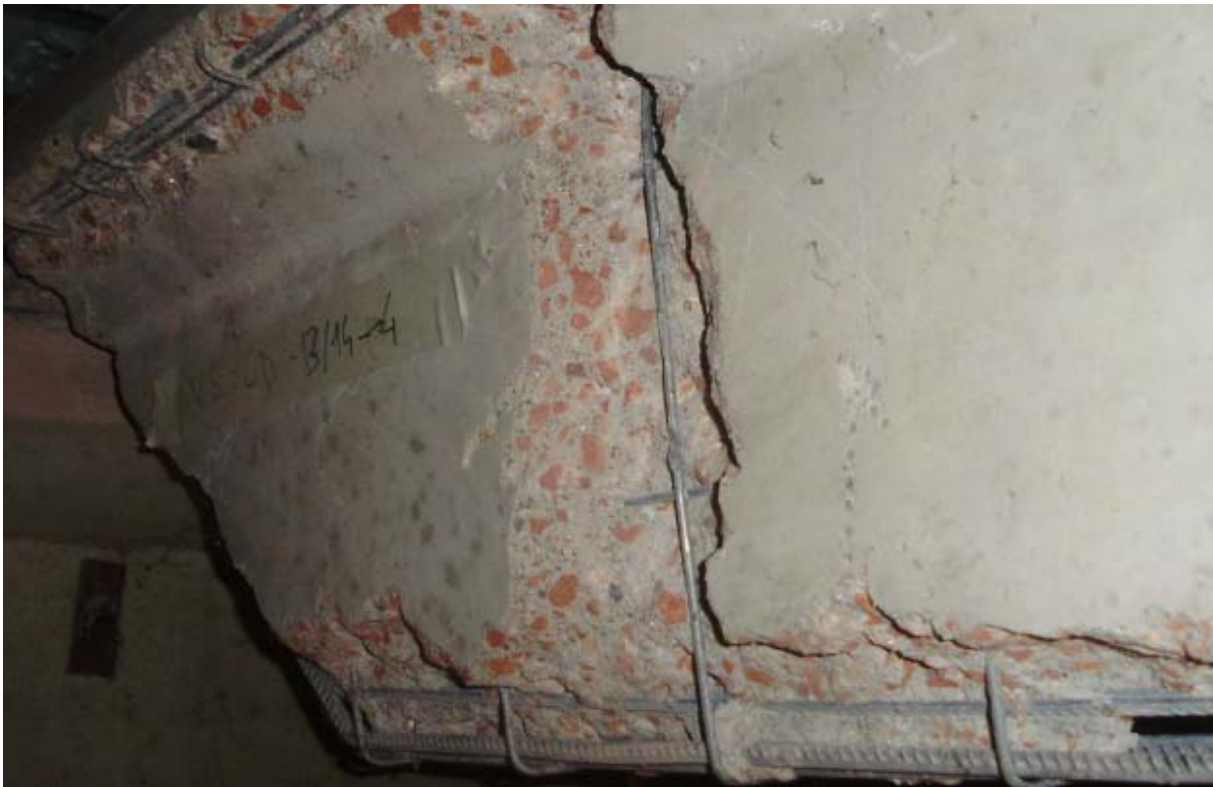
Figura 4. Inspección de vigas secundarias.
