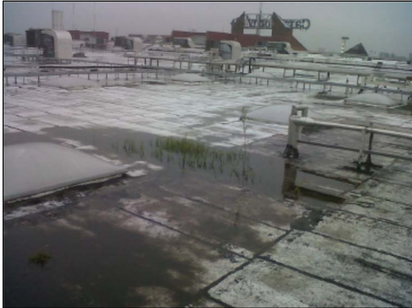
Figura 1. Vista exterior de la cubierta.
