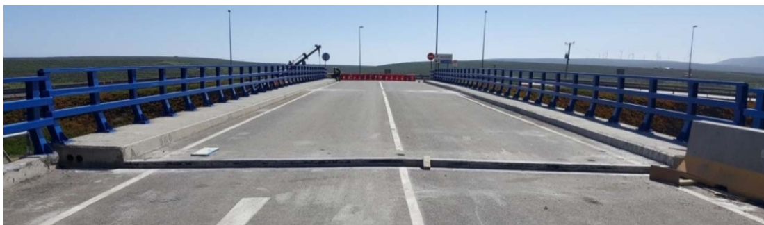
Figura 7. Vista superior después de la ejecución del ripado (ver marcas viales de calzada alineadas).
