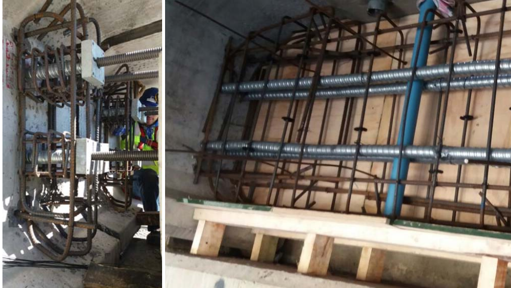
Figura 6. Ejecución de diafragmas.
