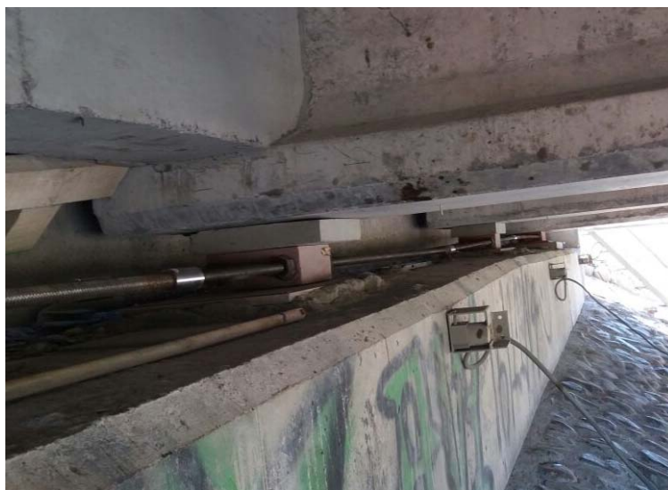
Figura 5. Bases deslizantes conectadas con barras y sensores de desplazamiento.
